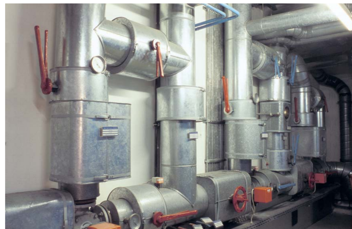
THERMALWASSER-HEIZUNGSANLAGE IM WIESBADENER RATHAUS
