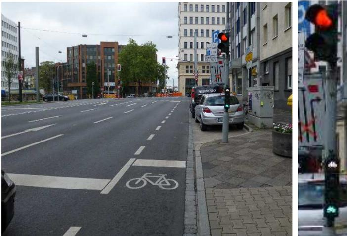
Die Realisierbarkeit von Fahrradschleusen ist stets im Einzelfall und unter Berücksichtigung der signaltechnischen Anforderungen und der Flächenverfügbarkeit zu prüfen. Je nach Ergebnis dieser Prüfung kann auch ein Vorbeiführen des Kfz-Linksabbiegers an der Schleuse erforderlich sein, in diesem Fall ist zusätzlich ein Radfahrstreifen für den links abbiegenden Radverkehr erforderlich
